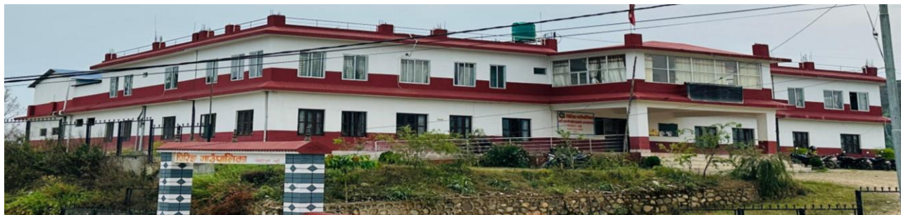
गा.पा. कार्यालय भवन संख्या १, भवन संरचना पक्की भएको
